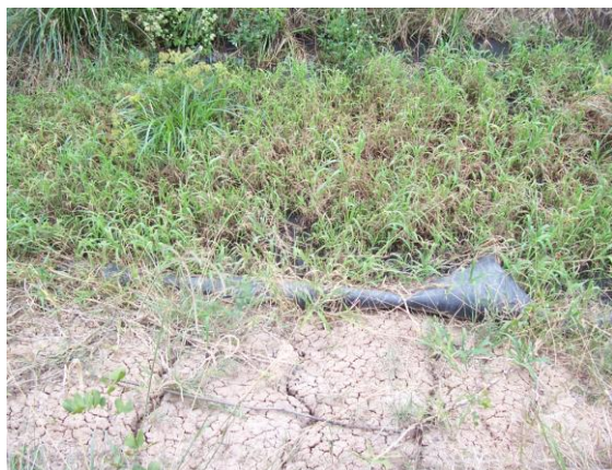
Imagen 2.29 Se observa el deterioro y desprendimiento de la membrana impermeabilizante.
