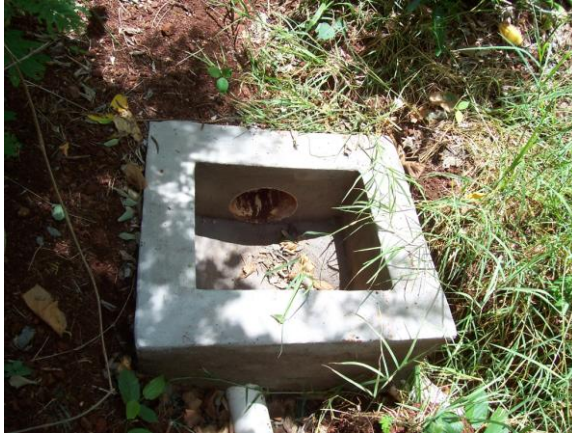
Imagen 2.38 Registro de inspección Fuente: Elaboración propia. Fotografía tomada el 14.01.2012
