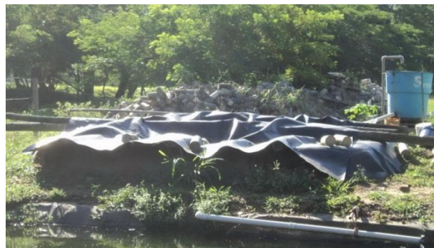
Imagen 2.49 Primera Fase: Laguna anaeróbica Dimensiones: Largo 2.4 mts.- Ancho: 2.4 mts. Profundidad: 1.90 mts. Fuente: Ing. Claudia Martínez.
