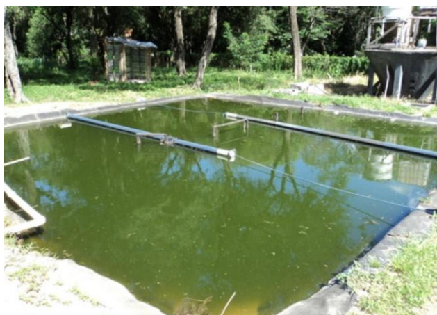
Imagen 2.50 Segunda Fase: Laguna Facultativa Dimensiones: Largo: 9.5 mts. – Ancho: 9 mts. Profundidad: 1.8 mts. Fuente: Ing. Claudia Martínez
