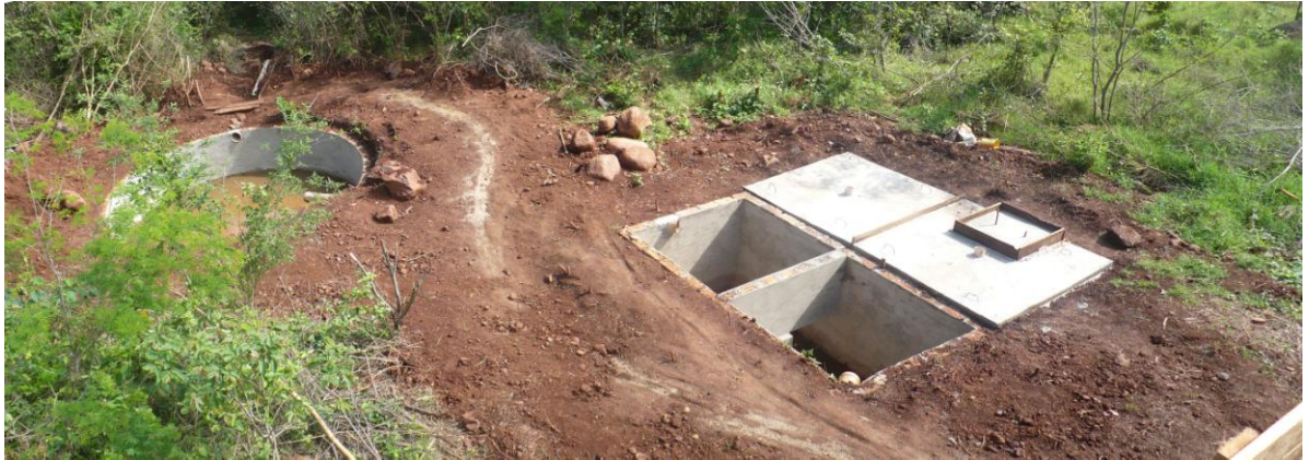
Imagen 2.32 Vista de la cámara séptica y del Filtro Verde Fuente: SENATUR
