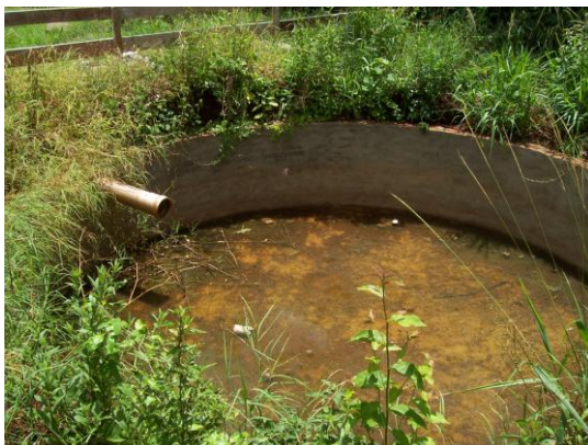
Imagen 2.42 Situación actual del Filtro Verde Fuente: Elaboración propia Fotografía tomada el 14.01.2012
