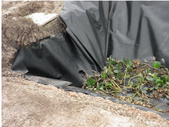
Imagen 2.21 Registro de inspección y punto de entrada del efluente.
