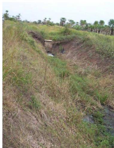
Imagen 2.28 Canal del Filtro Verde deteriorado por falta de mantenimiento.
