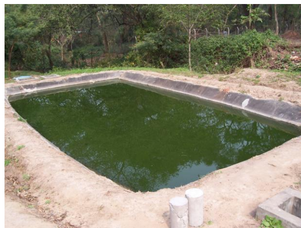
Imagen 2.51 Tercera Fase: Laguna de Maduración Dimensiones: Largo: 9 mts. – Ancho: 2.5 mts. Profundidad: 1.5 mts. Fuente: Elaboración propia. Fotografía tomada el 31.05.2011
