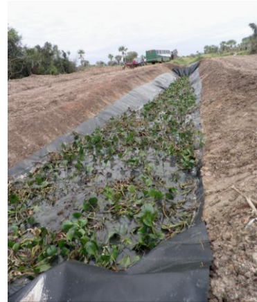
Imagen 2.22 Canal del Filtro Verde compactado e Impermeabilizado.
