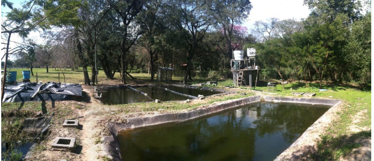
Imagen 2.46 Vista general del sistema de Lagunaje de la U.C.A. Fuente: Ing. Claudia Martínez.
