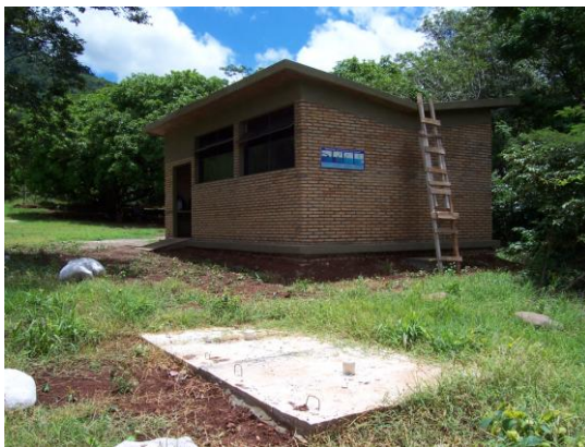
Imagen 2.33 Instalaciones sanitarias Fuente: Elaboración propia. Fotografía tomada el 14.01.2012
