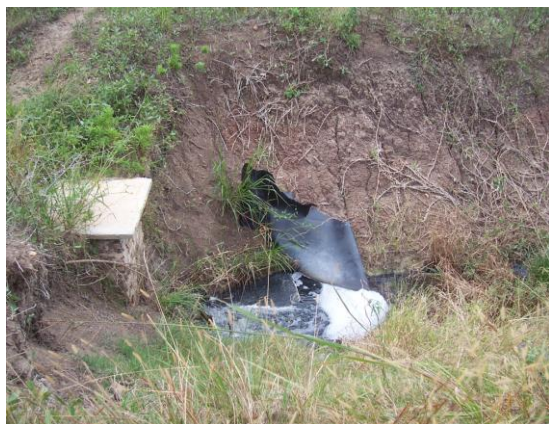
Imagen 2.27 Registro de inspección y punto de entrada del efluente.
