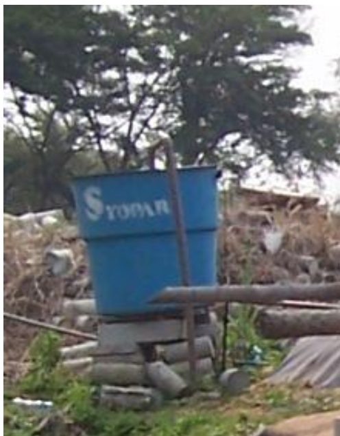
Imagen 2.48 Tanque de tratamiento preliminar. Capacidad: 500 litros. Fuente: Elaboración propia. Fotografía tomada el 13.05.2011
