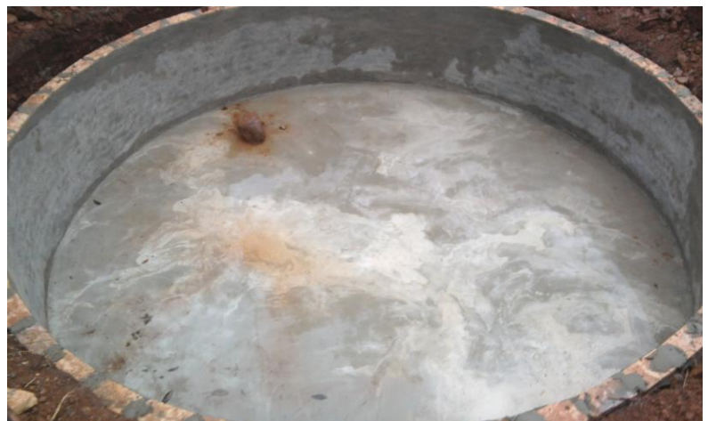
Imagen 2.37 Pileta de material para el Filtro Verde Fuente: SENATUR
